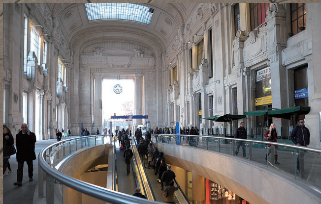
ミラノ中央駅舎。ファナズム期に建てられた荘厳な建築物。かつて車寄せだったスペースは、地下エリアへ繋がる大きな楕円の穴の開いた広場として再生。上下方向の動線の増設例。
